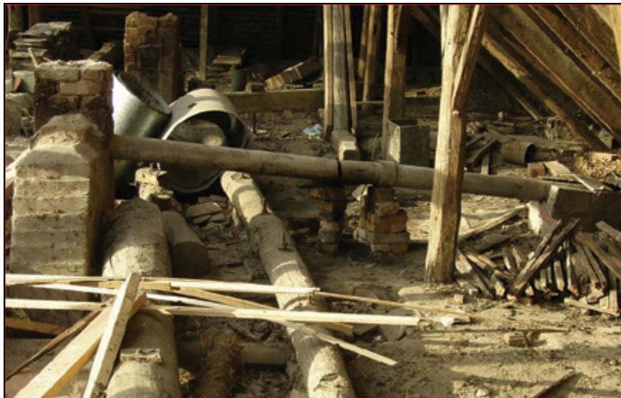
*Na slici 6 se vidi (dimnjača, fiks) koja ima pukotinu na salonitnoj cijevi kroz koju je kuljao dim prilikom korištenja.*
